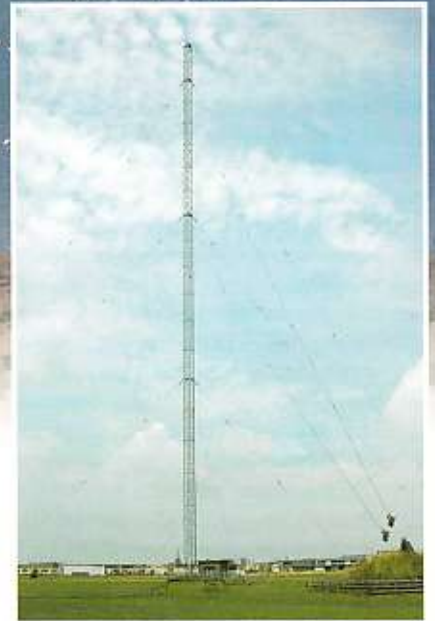
De noordelijke mast nog overeind
